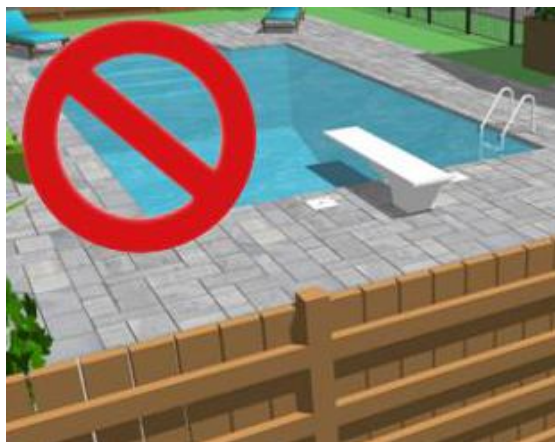
Exemple d'une clôture facilement escaladable.
