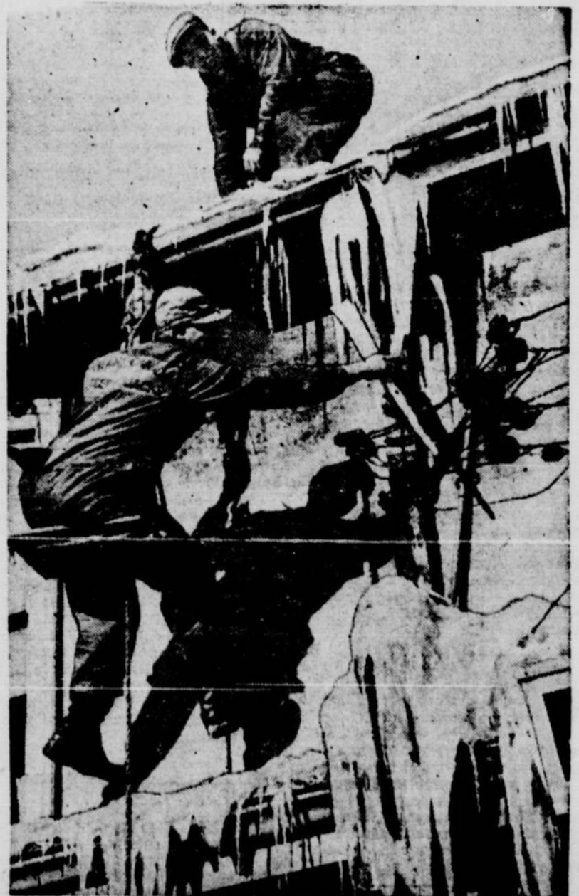
Al Iwach et son compagnon, Bob Green, grimpeurs de clochers, sont occupés ici à enlever la glace des toits afin de protéger la vie des pétons.
