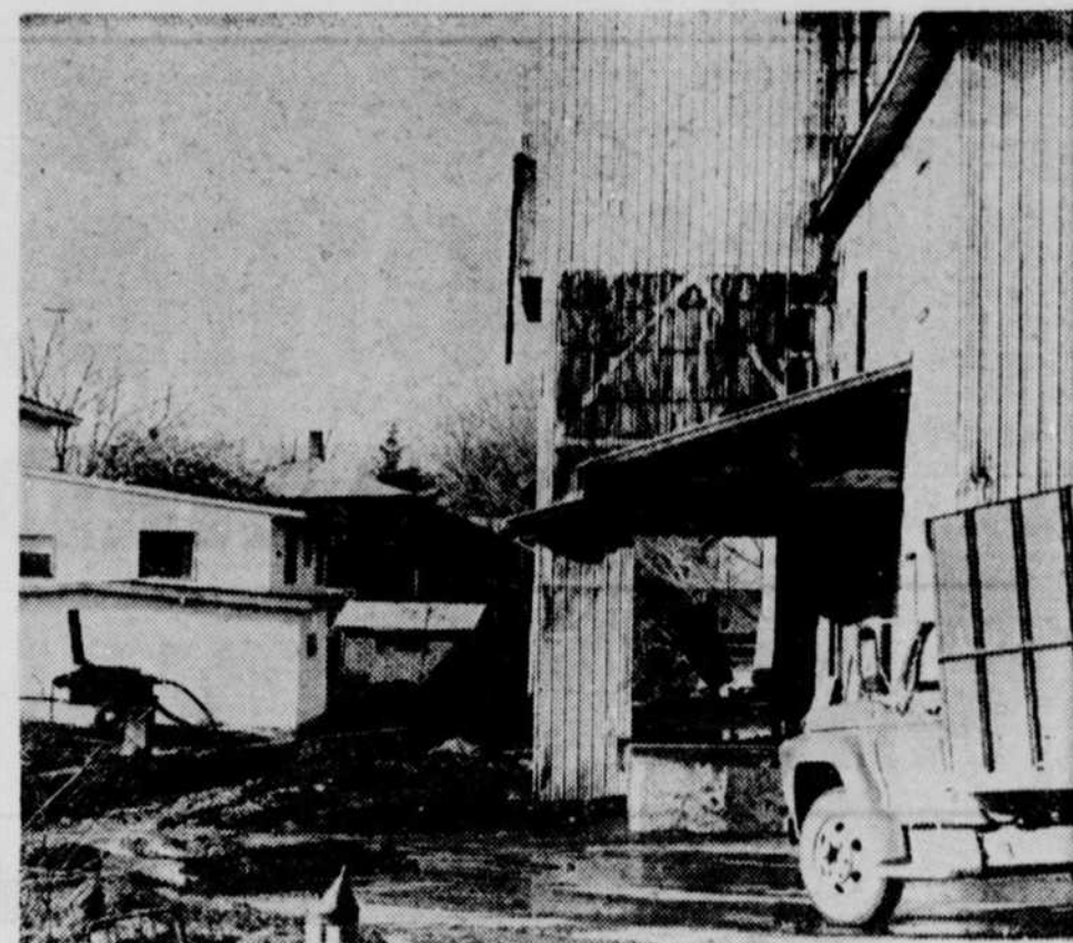
Les restes du silo de la meunerie coopérative de St-Bernard de Dorchester. Il semble que ce soit un court circuit, suivi d'une déflagration qui soient à l'origine du sinistre. (Photo Claude Parent)
