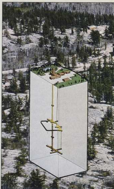
Le site des installations de surface avec le schéma du puits et des paliers d'expérimentation à 240 et 440 mètres.
