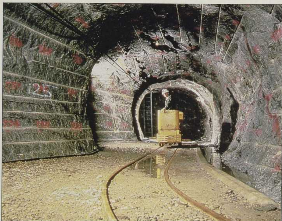
L'excavation du laboratoire souterrain du lac du Bonnet, où EACL effectue des essais d'enfouissement dans le roc.
