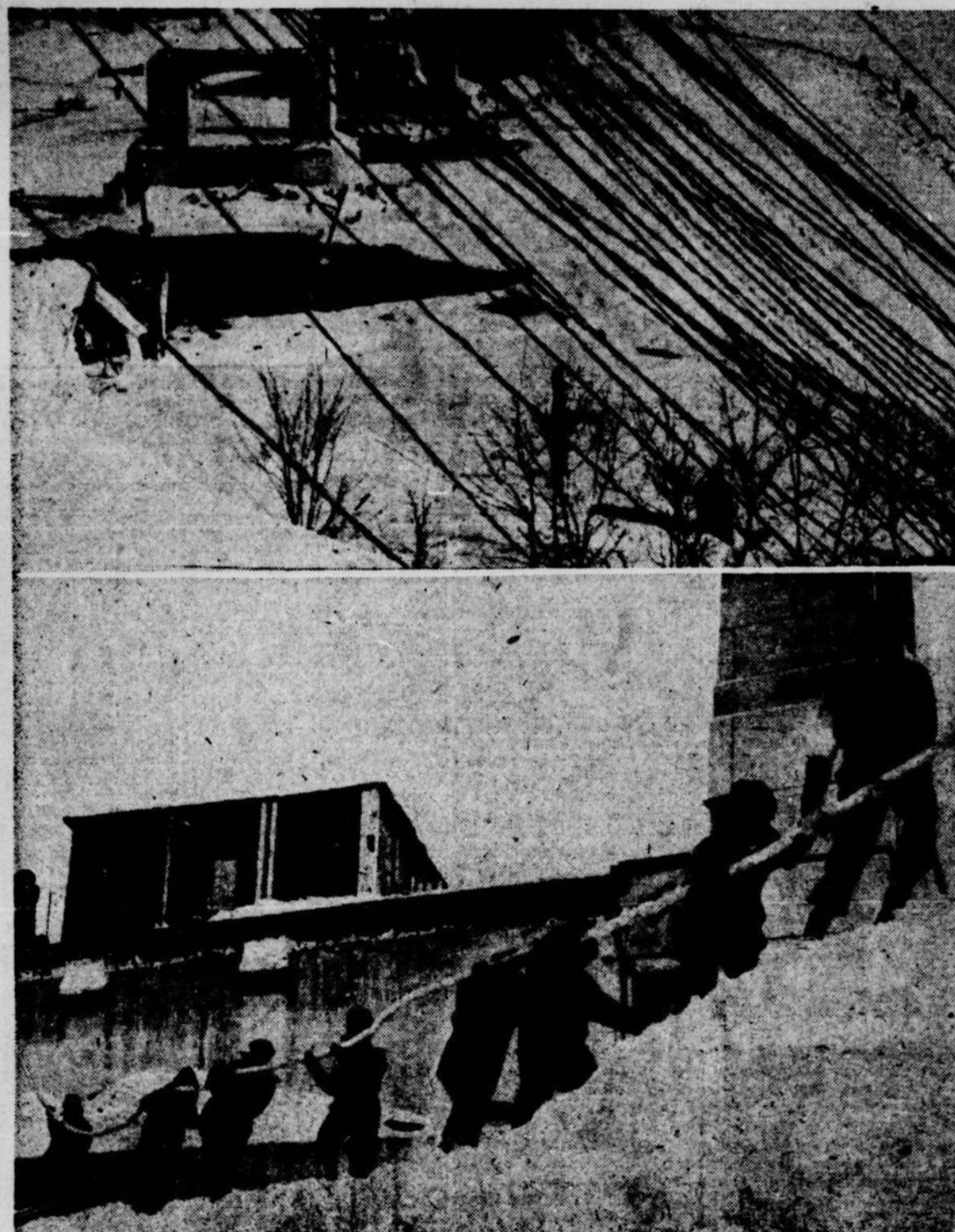
Ces photos illustrent les travaux entrepris par la Compagnie de téléphone Bell pour redonner l'usage du téléphone à ses clients du Cap-de-la-Madeleine, après l'effondrement du pont Duplessis. La photo du haut a une écloquence particulière. On y voit les piliers sans pont à travers d'innombrables fils et câbles du Bell. Jusqu'à mercredi matin, les câbles du téléphone
