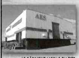
LE BÂTIMENT MOBILE DU SITE D'ENFOUSSEMENT DE CHICOUTIMI
