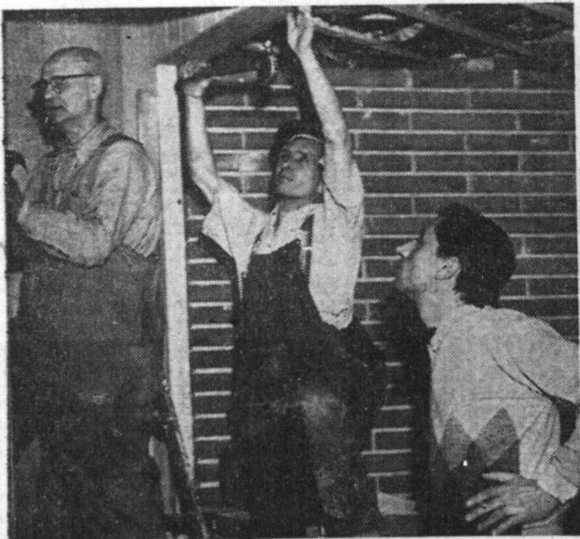
Enfin libre Roger est venu surveiller de près, la construction et la finition du sous-sol de sa maison. Apparemment satisfait du résultat obtenu, il n'a plus qu'une envie, que tout soit en place pour recevoir les copains !
