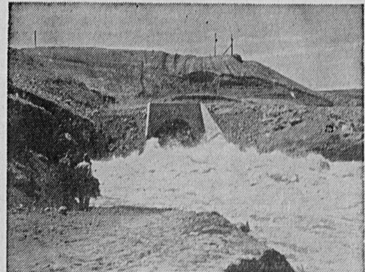
BARRAGE SUR LA WATERTON — Le barrage de la rivière Waterton, dernier ouvrage de grande envergure pour compléter le réseau d'irrigation des rivières St. Mary et Belly prend graduellement forme dans le sud-ouest de l'Alberta. Le canal illustré ici détourne les eaux de la rivière Waterton de l'emplacement de ce barrage qu'on édifie présentement à l'ombre des montagnes Rocheuses. Cette construction, dont le coût s'élève à 7 millions de dollars, ajoutera un potentiel d'irrigation de 7 millions de acres de surface de 195,000 acres en outre des 300,000 acres desservies par l'aménagement actuel. Un canal de quatre milles de longueur reliera le réservoir Waterton à la rivière Belly.
