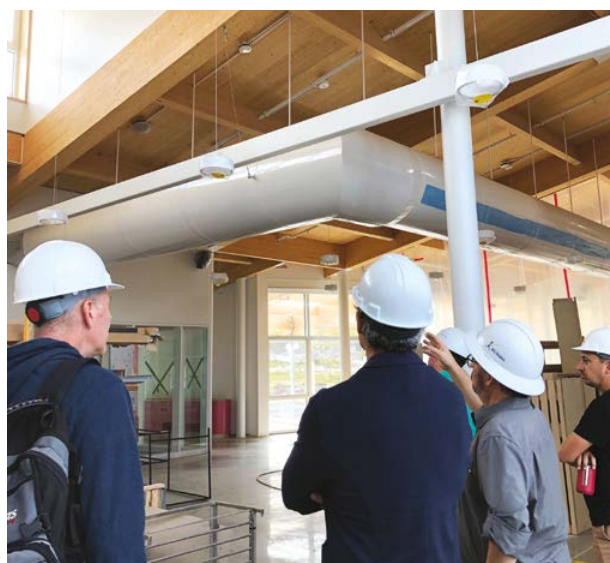
Visite de chantier, Lab-École Rimouski. © Lab-École
