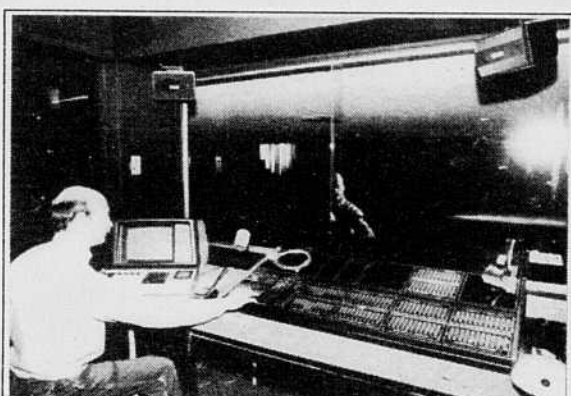
Le nouveau pupitre de commande d'éclairage.
