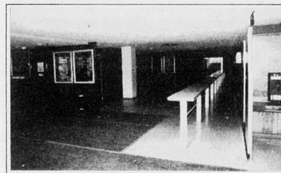
Le hall d'entrée, tel qu'il était avant les travaux.
