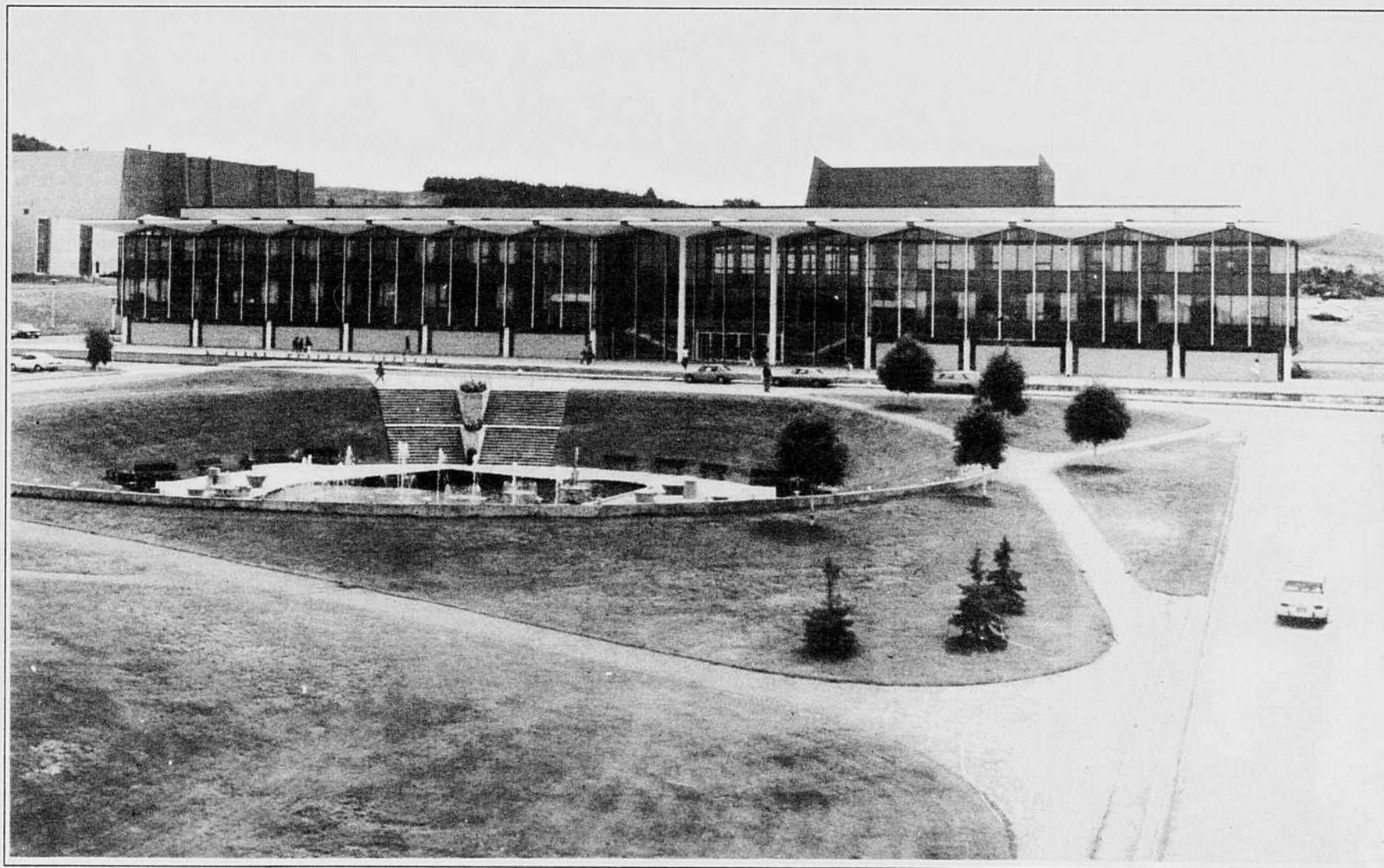
Entrée du Pavillon central donnant accès à la salle Maurice O'Bready.
