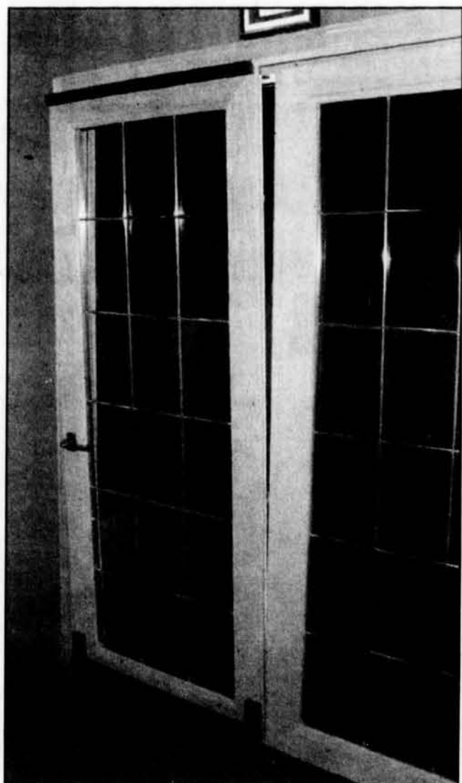
Portes françaises adoptant le design oscillo-battant polyvalent.
