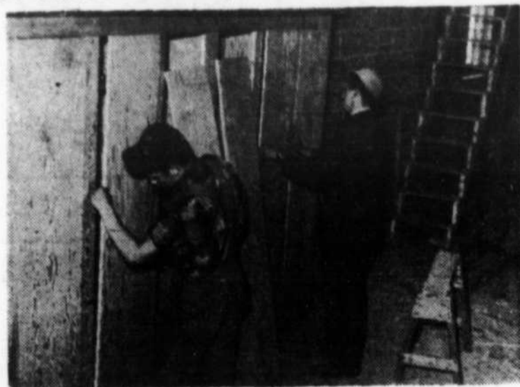
Deux apprentis menuisiers qui sauront comment faire des portes de garde-robe quand ils se trouveront sur un chantier de construction. Photo prise au Centre d'Apprentissage de Sherbrooke.
