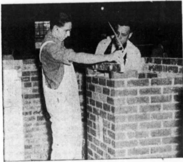
Apprentis briqueteurs apprenant à faire un mur bien droit au Centre d'Apprentissage des Métiers du Bâtiment de Montréal.
