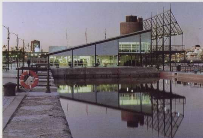
LA MAISON DES ÉCLUSIERS, VIEUX-PORT DE MONTRÉAL CARDINAL HARDY ET ASSOCIÉS, ARCHITECTES
