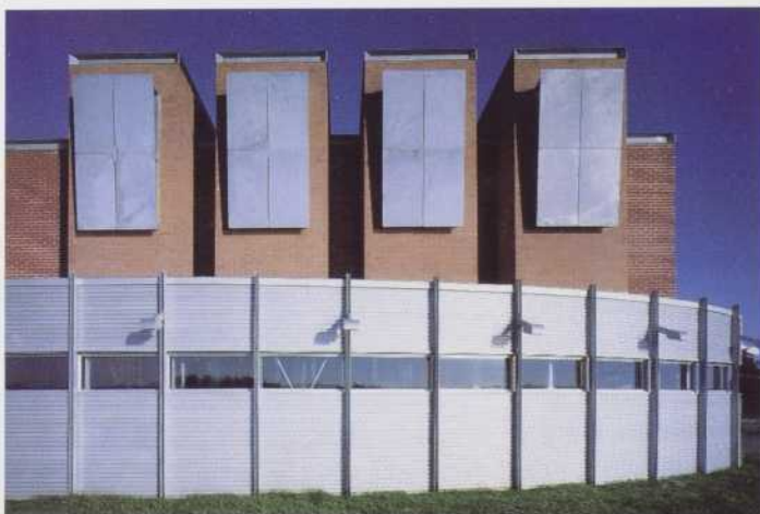
STATION D'ÉPURATION DES EAUX DE TERREBONNE BIRTZ, BASTIEN, ARCHITECTES
