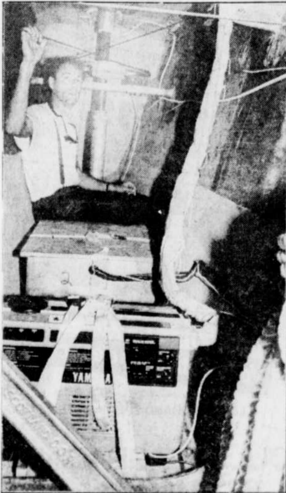
Marc Perron, à l'intérieur de la coque tribord, là où l'on retrouve le groupe électrogène.
