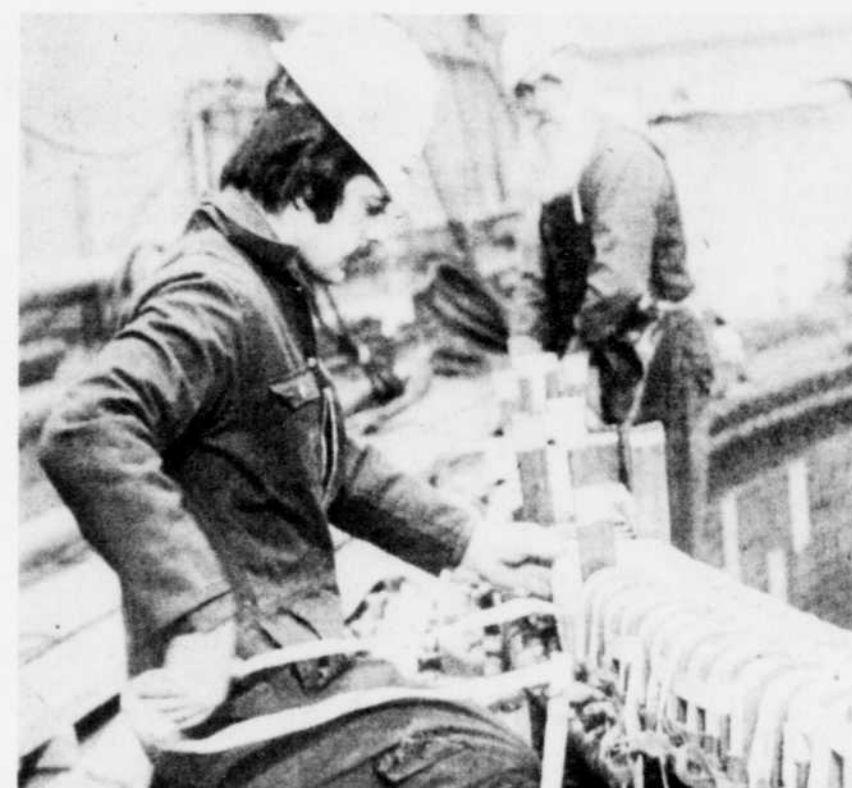
Deux ouvriers spécialisés font le montage des conducteurs de cuivre et des pièces isolantes du stator d'un groupe turbine-alternateur. Le premier groupe doit tourner vers le 20 juin, à la centrale LG-3.
