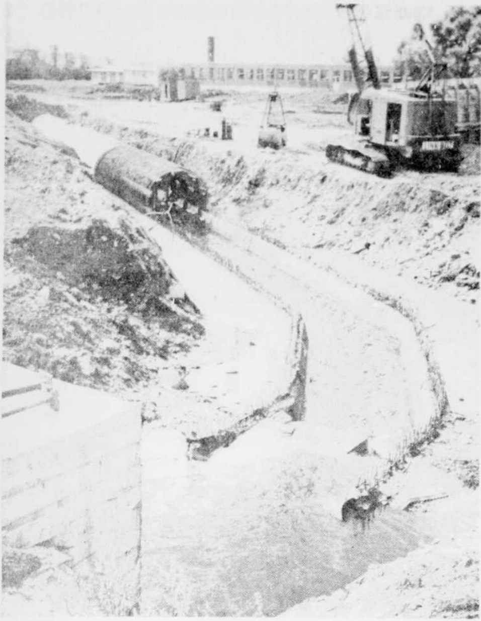
TRAVAUX AVANCÉS — Les travaux de construction de l'intercepteur principal d'égouts, actuellement en cours le long de la rivière Yamaska, progressent rapidement. Comme on peut le voir ci-haut, la première section du projet qui reliera l'égout de la rue Robinson au nouvel intercepteur jusqu'à la rue St-Urbain, est presque déjà complétée. La bouche de sortie de l'égout Robinson (à gauche de la photo) sera reliée directement à l'intercepteur principal dont la base est déjà coulée, éliminant ainsi les odeurs nauséabondes qui se dégagent à cet endroit, depuis plusieurs années déjà. (Photo La Tribune, par F. Aubin, Granby)
