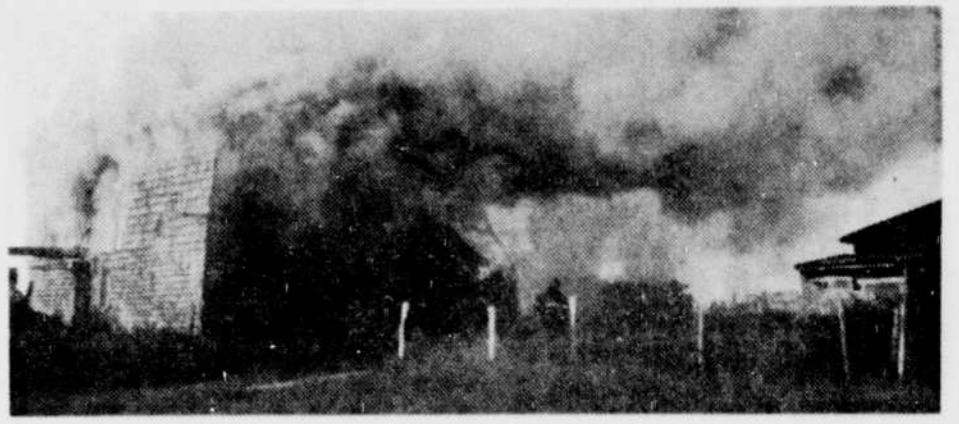
Au plus fort de l'incendie.
