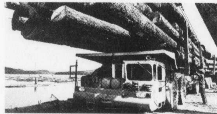
Ce camion avec remorque, l'un des plus gros du monde, transporte plus de 250 tonnes de bois rond par voyage. Conduit par des chauffeurs spécialement qualifiés, il a été conçu en Colombie-Britannique pour répondre aux particularités du sol canadien.
