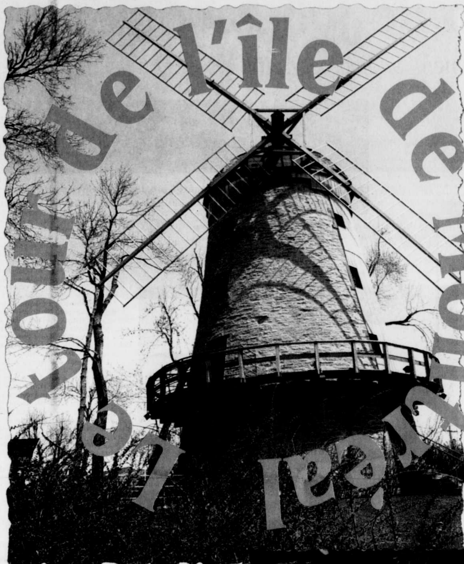
Photo Pierre Côté Le moulin Fleming, à La Salle, est le seul de type anglais qui subsiste encore au Québec.
