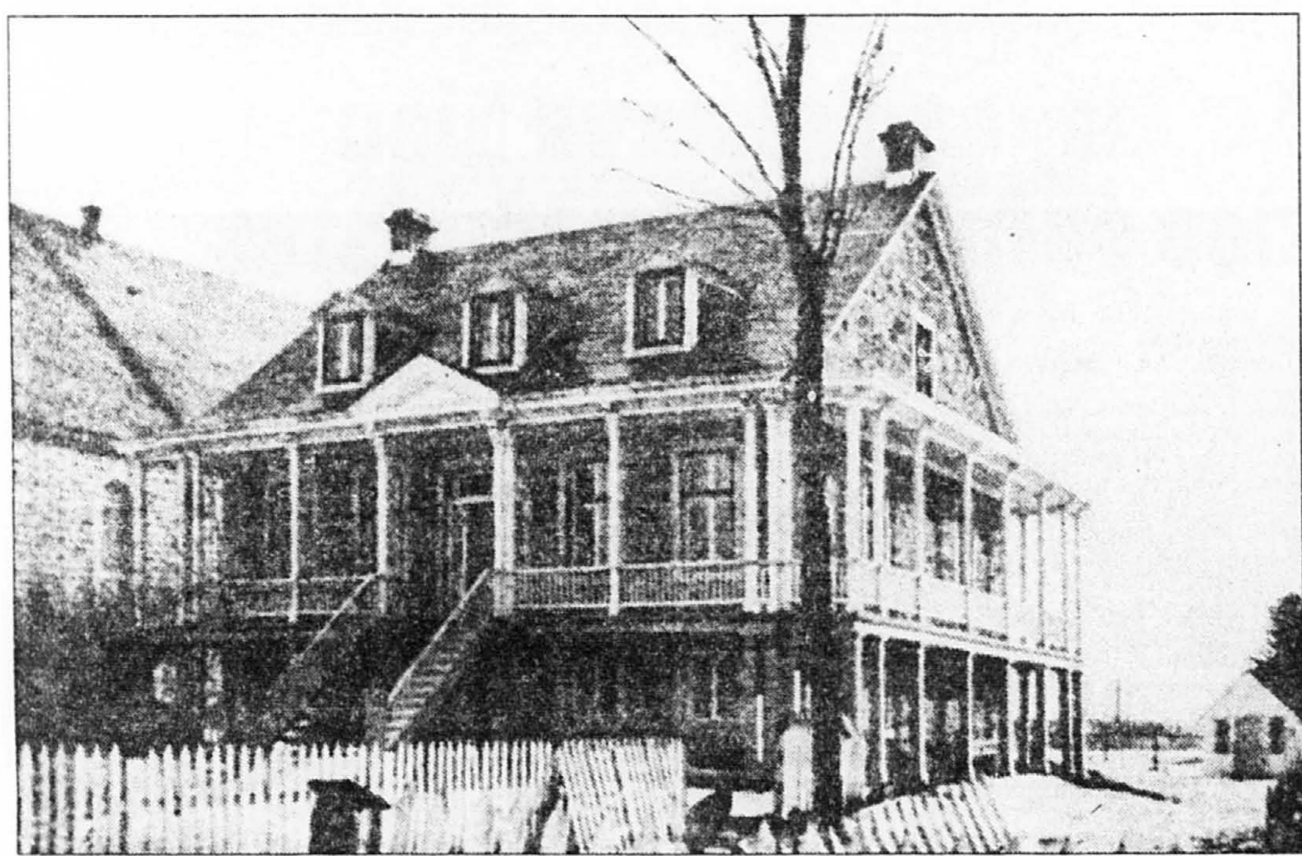
Le bâtiment en pierre au rez-de-chaussée est couvert d'un toit à deux versants, dont la ligne faîtière est entrecoupée de deux cheminées.
