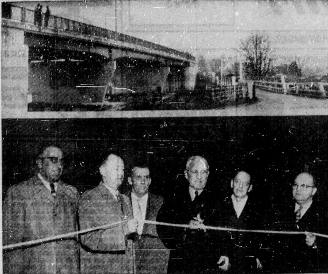
ON INAUGURE UN NOUVEAU PONT A MANOTICK — Le ministre ontarien de la Voirie, l'hon. James N. Allan, a coupé hier après-midi le ruban inaugural du nouveau pont traversant la rivière Rideau à Manotick. Sur la photo du haut, on voit l'ancien pont et le nouveau; en bas, de gauche à droite, M. Erskine Johnston, député provincial de Car-
