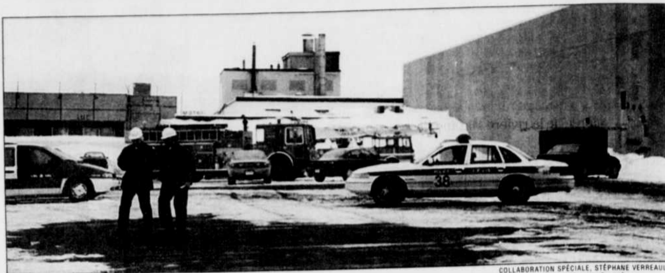
C'est une section de 50 pieds sur 50 qui s'est effondrée, vers 10 h, tombant sur une nouvelle chaîne de production. Les dégâts pourraient s'élever à plusieurs dizaines de milliers de dollars.
