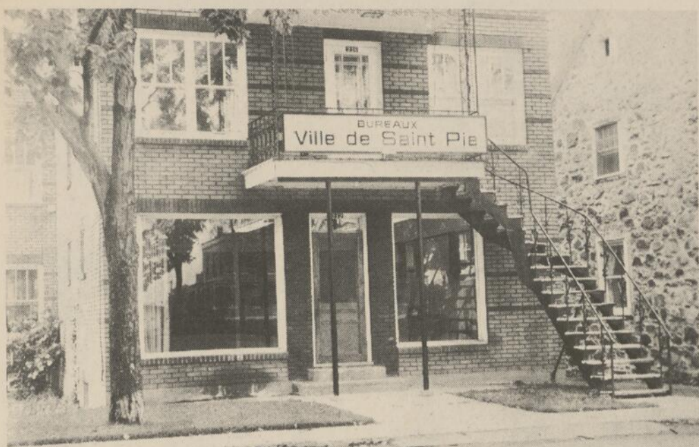
NOUVEL HOTEL DE VILLE — La ville de St-Pie, dans le comté de Bagot, possède maintenant son nouvel hôtel de ville. L'édifice, qui a nécessité un investissement total de $25,000, est pratiquement terminé et renferme les bureaux administratifs du village, de la paroisse et de la Commission scolaire de St-Pie. Cette vignette nous montre l'aspect général de l'extérieur, ainsi que la façade du nouvel hôtel de ville, lequel est situé au 212, rue Notre-Dame. En dépit de l'âge assez avancé de cette bâtisse, il n'en demeure pas moins vrai qu'elle est encore en excellente condition.
