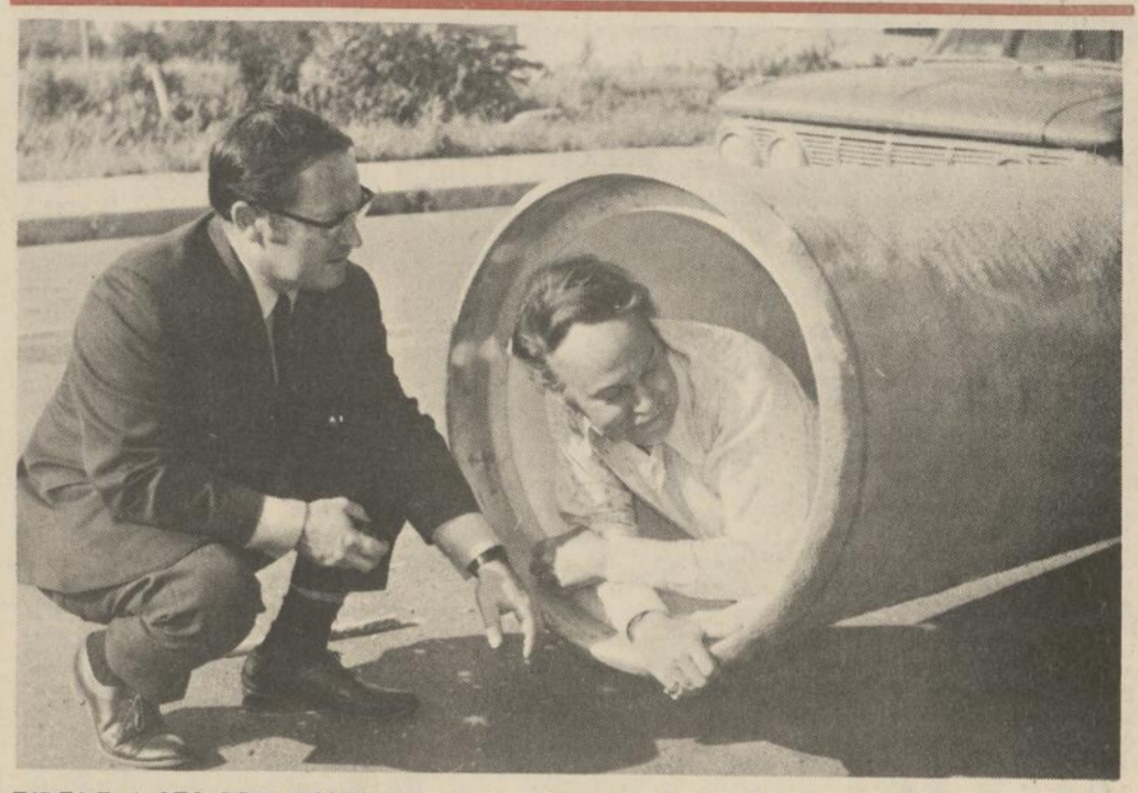
FIDELE A SES PROMESSES électorales, le maire de Granby conserve jusqu'à la fin de son terme un grand souci de la qualité de l'eau livrée aux consommateurs de la ville. Et c'est pourquoi M. Paul-O. Trépanier s'est introduit dans une conduite neuve prête à être mise en place boulevard Fortin. Large d'un diamètre de 24 pouces, ce tuyau en Hyprescon comprend une armature en acier galvanisé recouverte de ciment gris et enduite à l'intérieur d'un revêtement parcellisé ne s'altérant pas avec le temps ni l'usage. M. François Lande, ingénieur conseil, ayant conçu les plans de la conduite, explique au maire le principe la pose des joints étanches.
