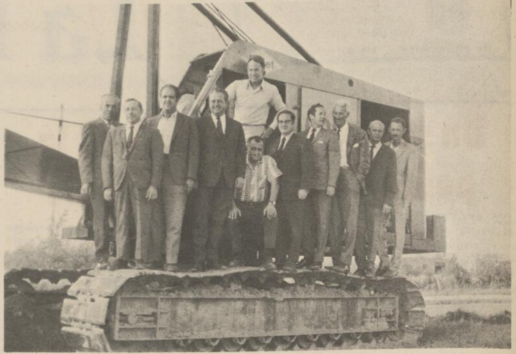
PREMIERE PHASE D'UN TRES ANCIEN PROJET, la construction d'une conduite d'aqueduc allant de l'usine de filtration à l'extrémité actuelle du boulevard Fortin, à Granby, a été entreprise hier.
