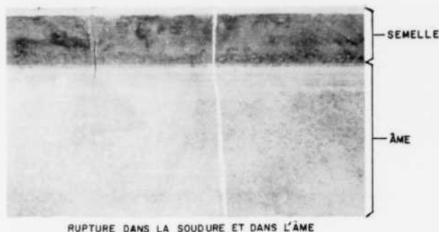
Fig. 11 : Fissure en fatigue d'une poutre laminée.
