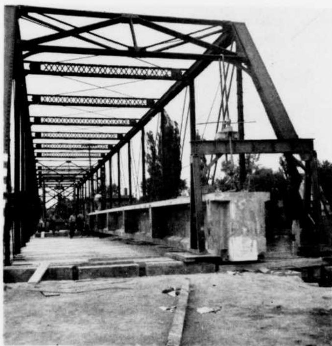
Fig. 3 — Mise en place des premières poutres utilisant l'ancien pont qui fut démoli par la suite
