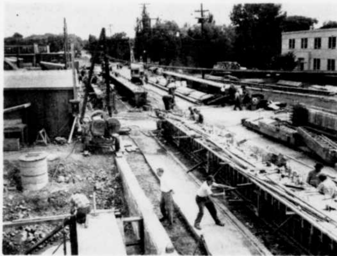
Fig. 2 — Chantier de fabrication des poutres
