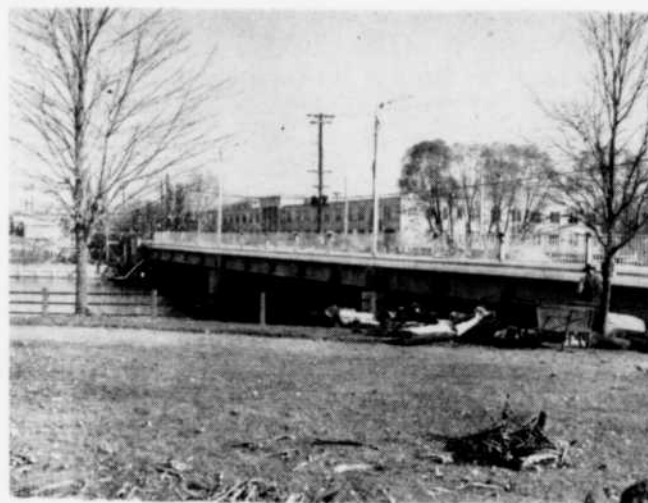
Fig. 8 — Pont sud terminé
