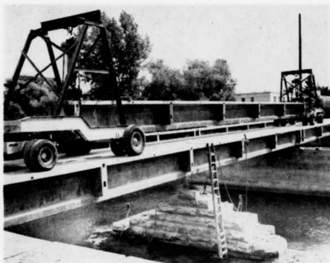
Fig. 4 — Transport d'une poutre en place
