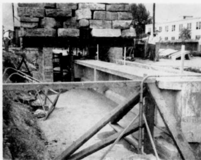
Fig. 5 — Poutre mise à l'essai
