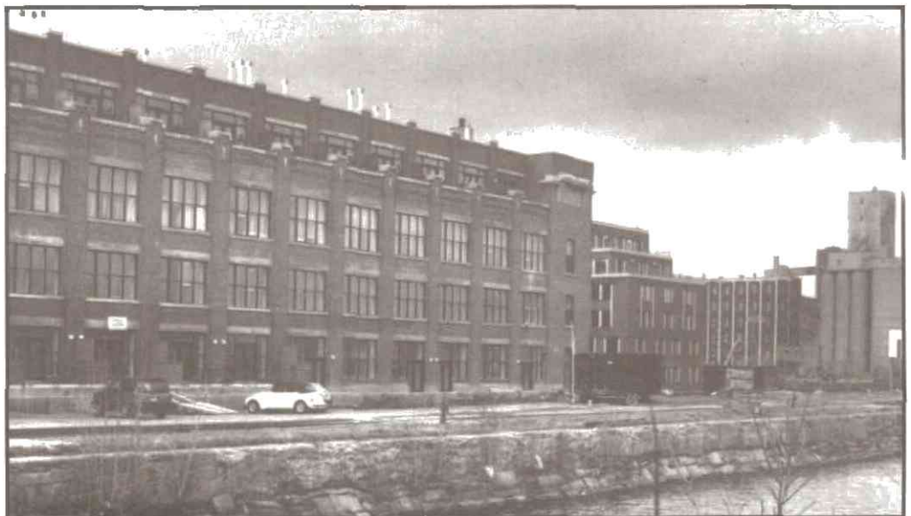
PHOTO 7 Canal Lachine: ancienne usine recyclée en «condominiums»
