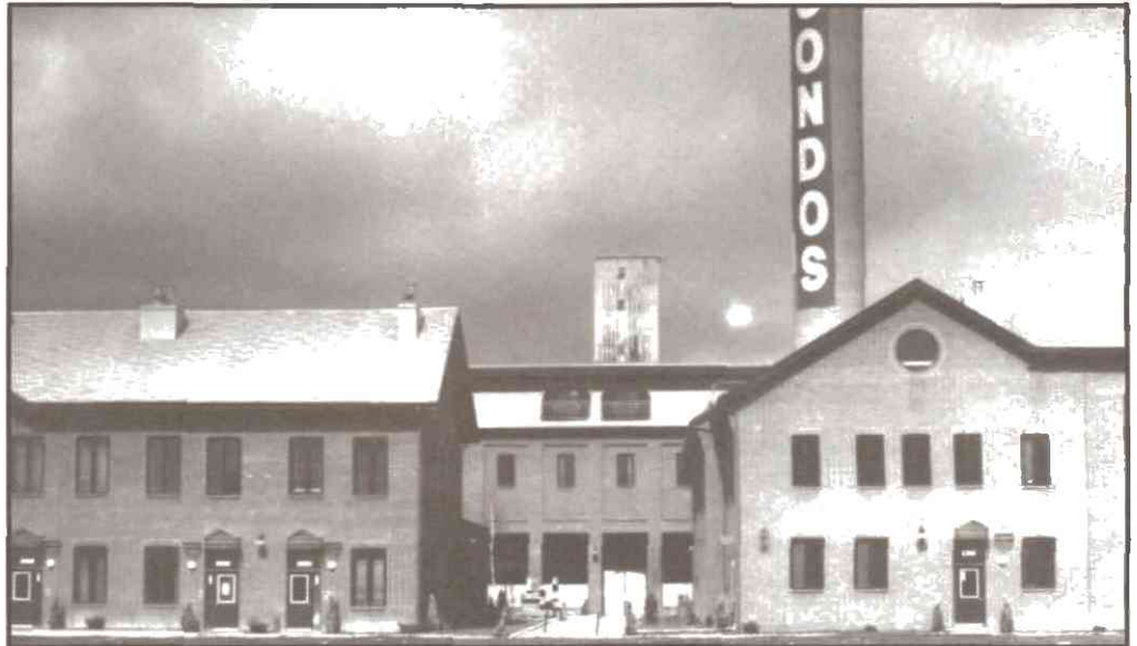
PHOTO 6 Canal Lachine: ensemble neuf de logements en copropriété
