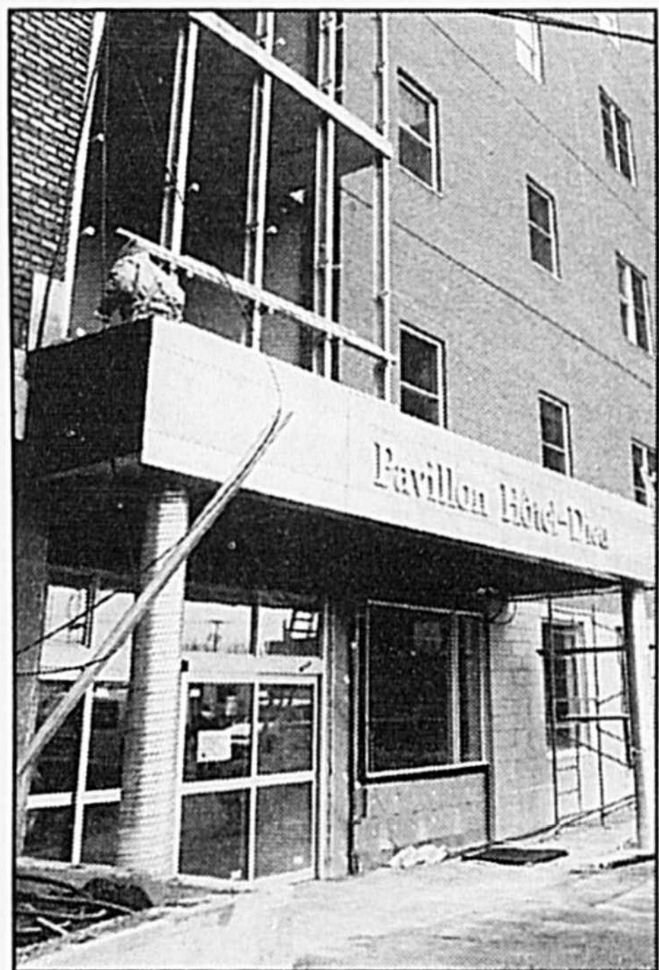
L'entrée principale du pavillon Hôtel-Dieu sera bientôt relocalisée de la rue Dessaulles à la rue Sainte-Anne. Les visiteurs accéderont au pavillon par le hall qui fera la jonction entre le nouveau bloc A et les anciens bâtiments.
