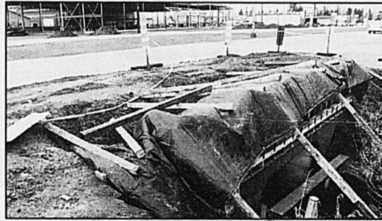
Des travaux de démantèlement de la passerelle de bois ont été nécessaires au milieu de la dernière semaine en bordure du boulevard Laurier, dans le secteur Douville. Il y avait danger d'affaissement de la chaussée.
