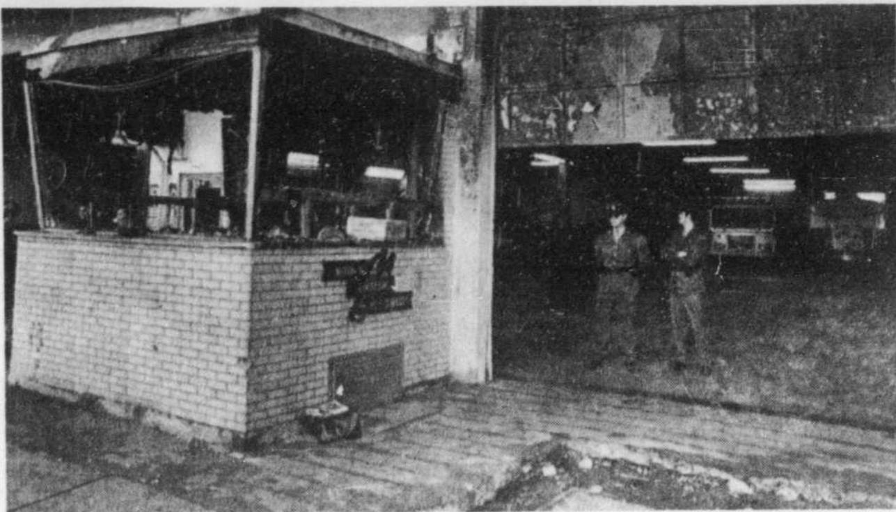
Deux agents de la Sûreté du Québec montaient la garde, hier matin, devant l'immeuble de la Murray Hill lourdement endommagé lors de l'émeute qui s'est déclenchée mardi soir lors d'une manifestation du Mouvement de libération du taxi. (Photo PC)
