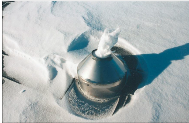
FIGURE 4.7 : FORMATION DE GLACE À LA SORTIE DE L'ÉVENT SOURCE : SHQ
