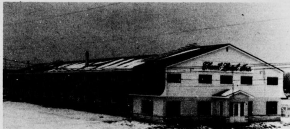
Le chenil Laval comprend un bureau de réception et une salle d'accouplement et d'accouchement pour les chiens de race.
