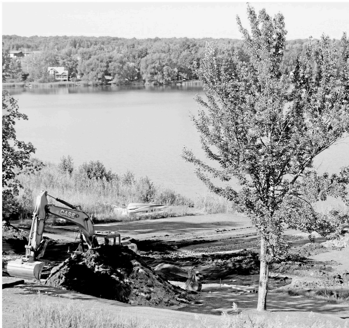
Les jardins intelligents, aussi connus sous le nom de jardins de pluie ou aire de biorétention, permettent de capter le phosphore des eaux de ruissellement. On voit ici celui réalisé par le promoteur du quartier Chambourg sur le lac, sur la rive opposée à celle de la plage municipale. — PHOTO ARCHIVES LA VOIX DE L'EST
