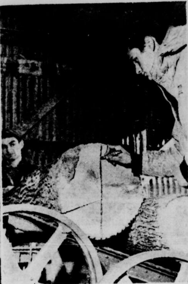
Pour obtenir à la coupe la meilleure partie du bois, on sciera la bille en croix.
