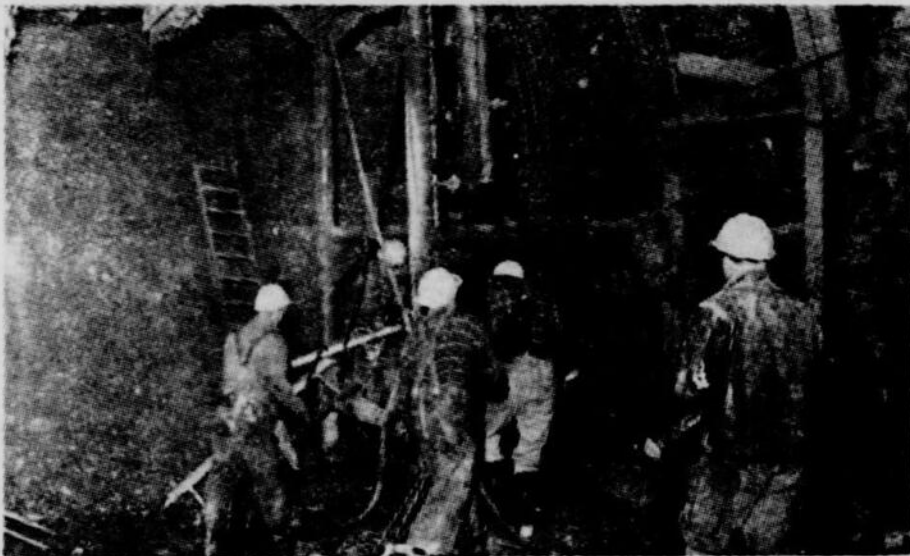
Cette arche de fer supporte la coupole là où le rocher est d'une qualité douteuse. Au fond, la paroi, à laquelle s'attaqueront les foreuses.
