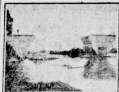
Pont détruit dans l'Aisne.
