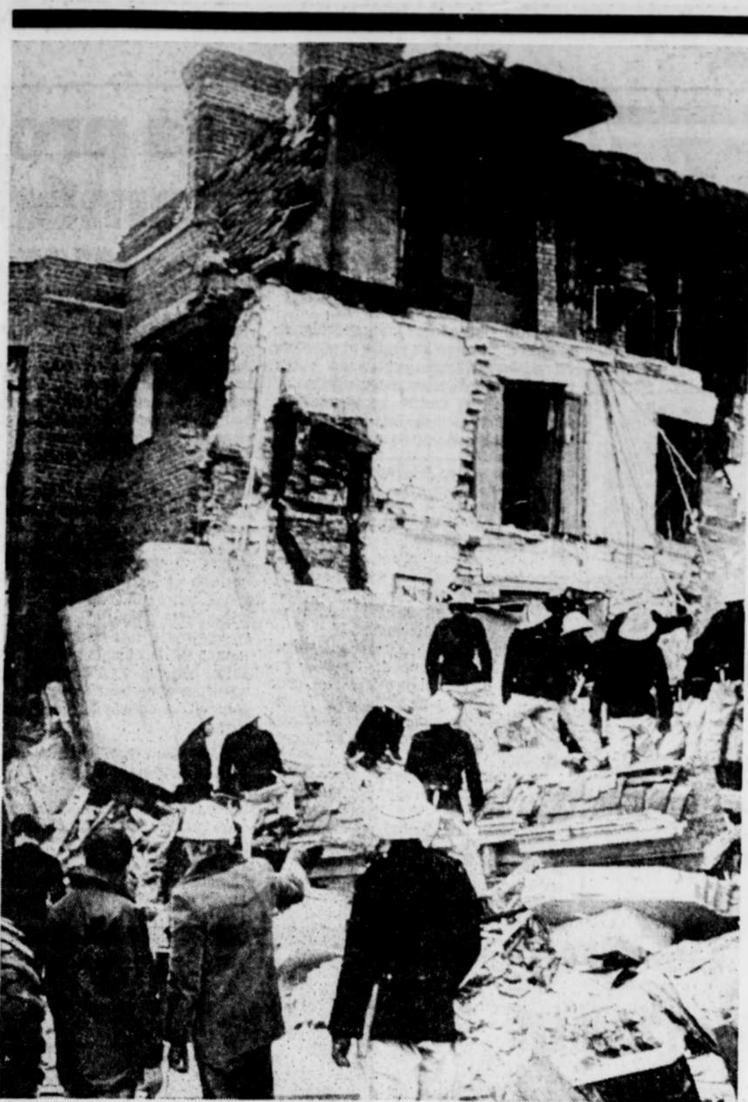
Les équipes de secours et les pompiers ont travaillé toute la journée pour retirer les corps des décombres, dans cette maison du quartier londonien de Putney.
