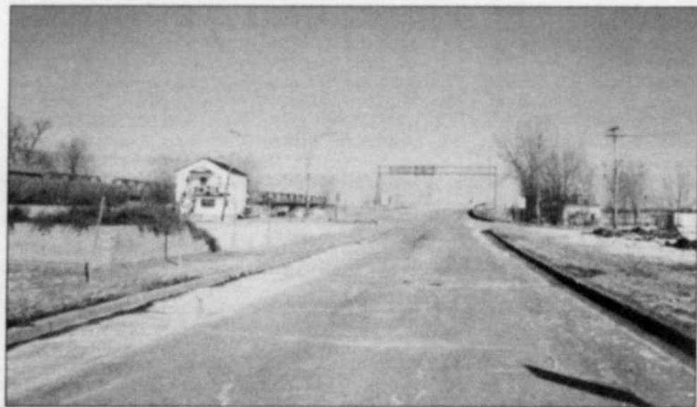
Il faudra déterminer si les approches du pont Le Gardeur se prêteraient bien à une configuration variable du sens de voies de circulation. Ici, l'approche de ce pont vue de Pointe-aux-Trembles. (Photo: Richard Gauthier)
