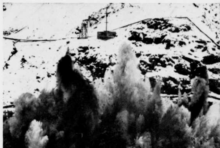
On a fait sauter deux bouchons de roc qui retenaient les eaux de la Manicouagan pendant la construction des tunnels de dérivation au moyen de 14,000 livres d'explosifs brisants C-I-L. Les tunnels étaient prêts pour l'Hydro-Québec un mois avant la date limite.
