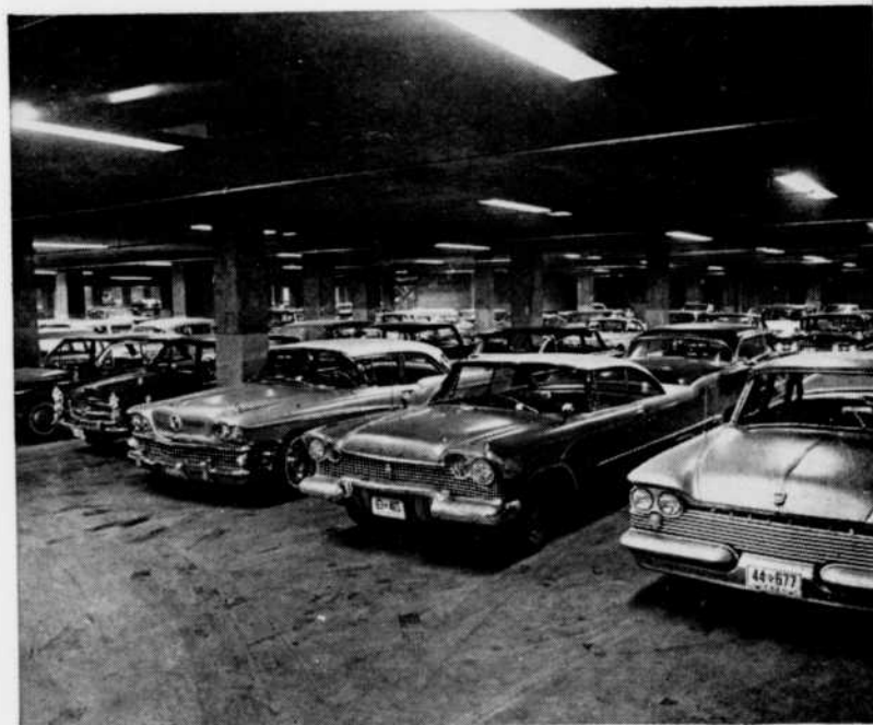
Les colonnes d'acier de cet immeuble à plusieurs étages permettent de disposer d'un espace utile plus grand.
