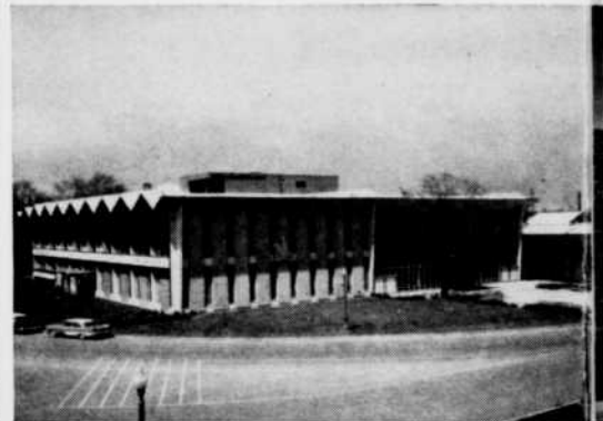
Le pavillon Queen Elizabeth au terrain de l'exposition de Toronto. Architectes: Page & Steele . Ingénieurs-conseils: Hooper & Yolles . Entrepreneurs généraux: Hughes Construction Company Ltd.
