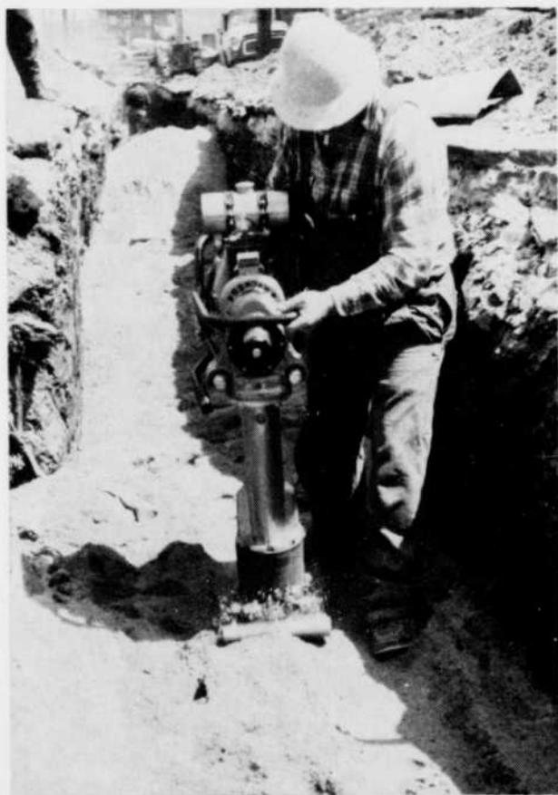
6 — Compaction de la terre de remplissage.
