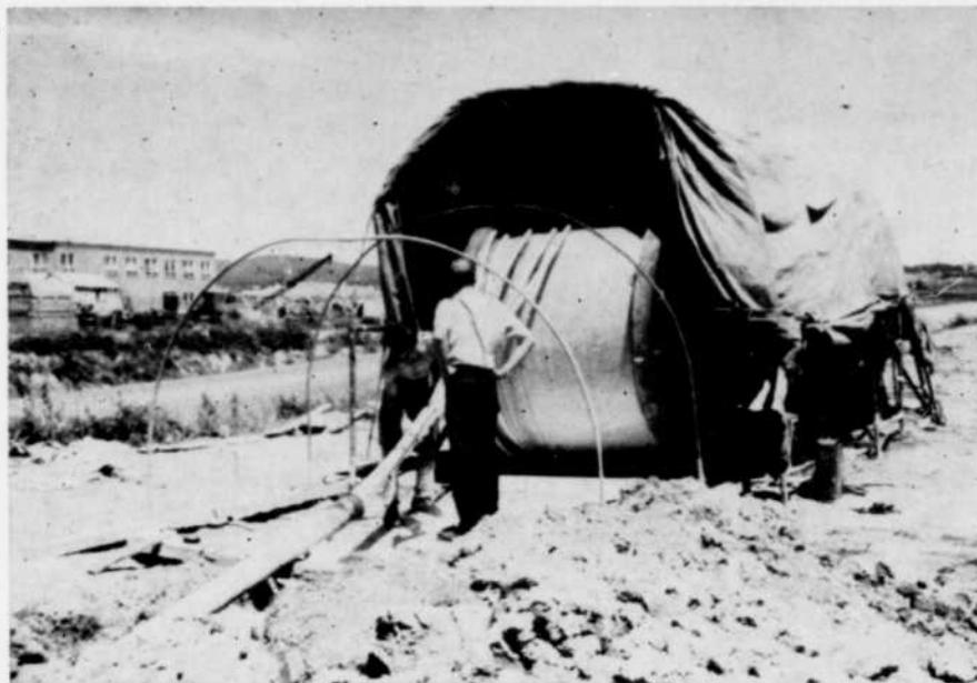
7 — Les trois bobines contenant chacune des conducteurs sont placées en ligne et les conducteurs sont tirés ensemble dans le tuyau.
