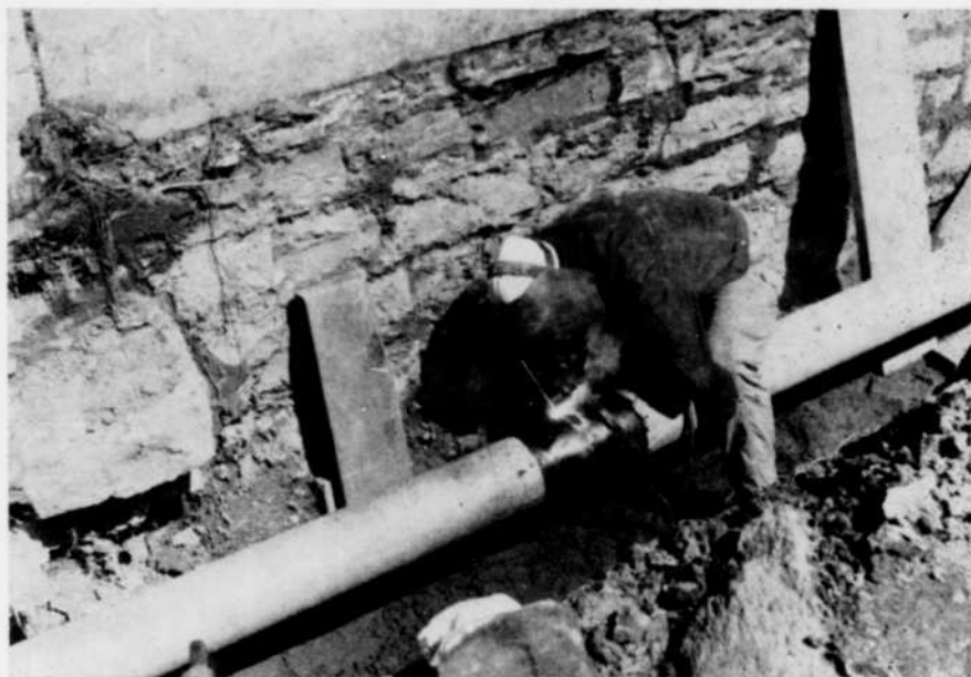
2 — Les sections de tuyaux doivent être jointes au moyen d'une soudure parfaitement étanche.
