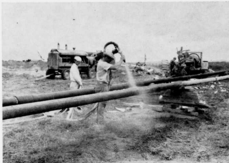
5 — Pour la portion de la traversée de la rivière, le tuyau reçoit une couche protectrice de béton.
