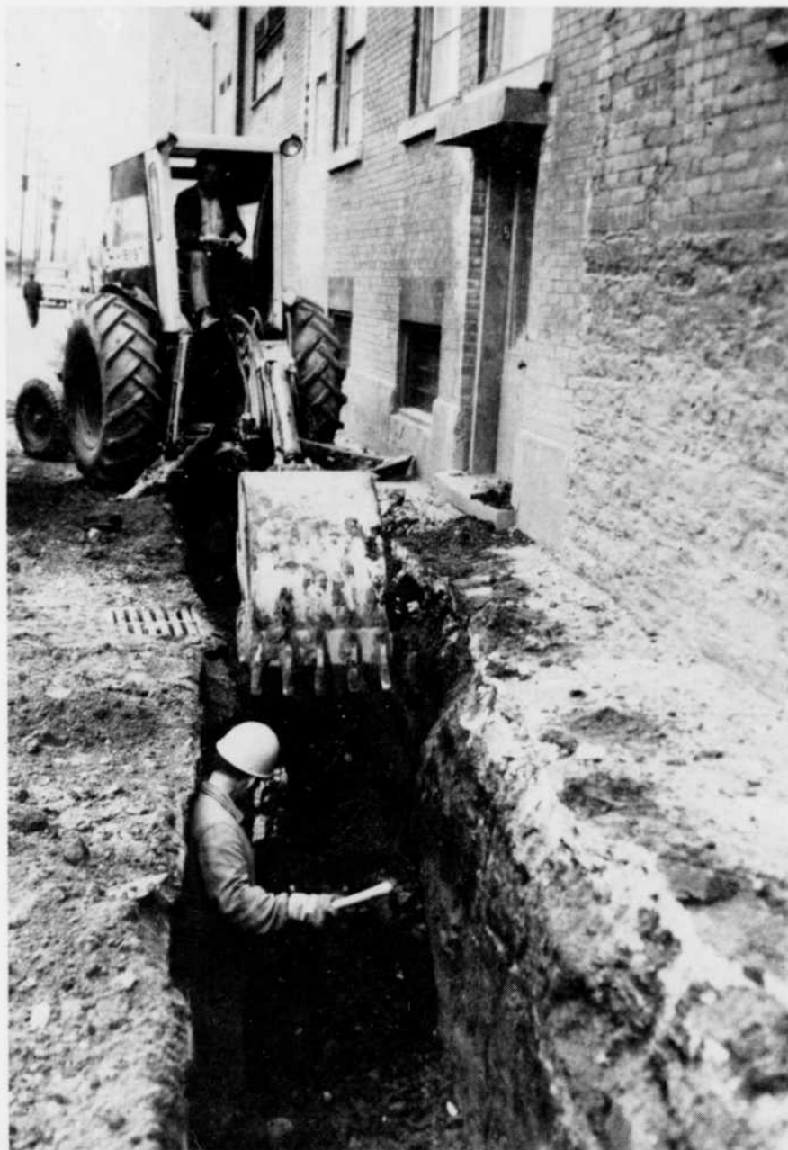
3 — Creusage de la tranchée.
