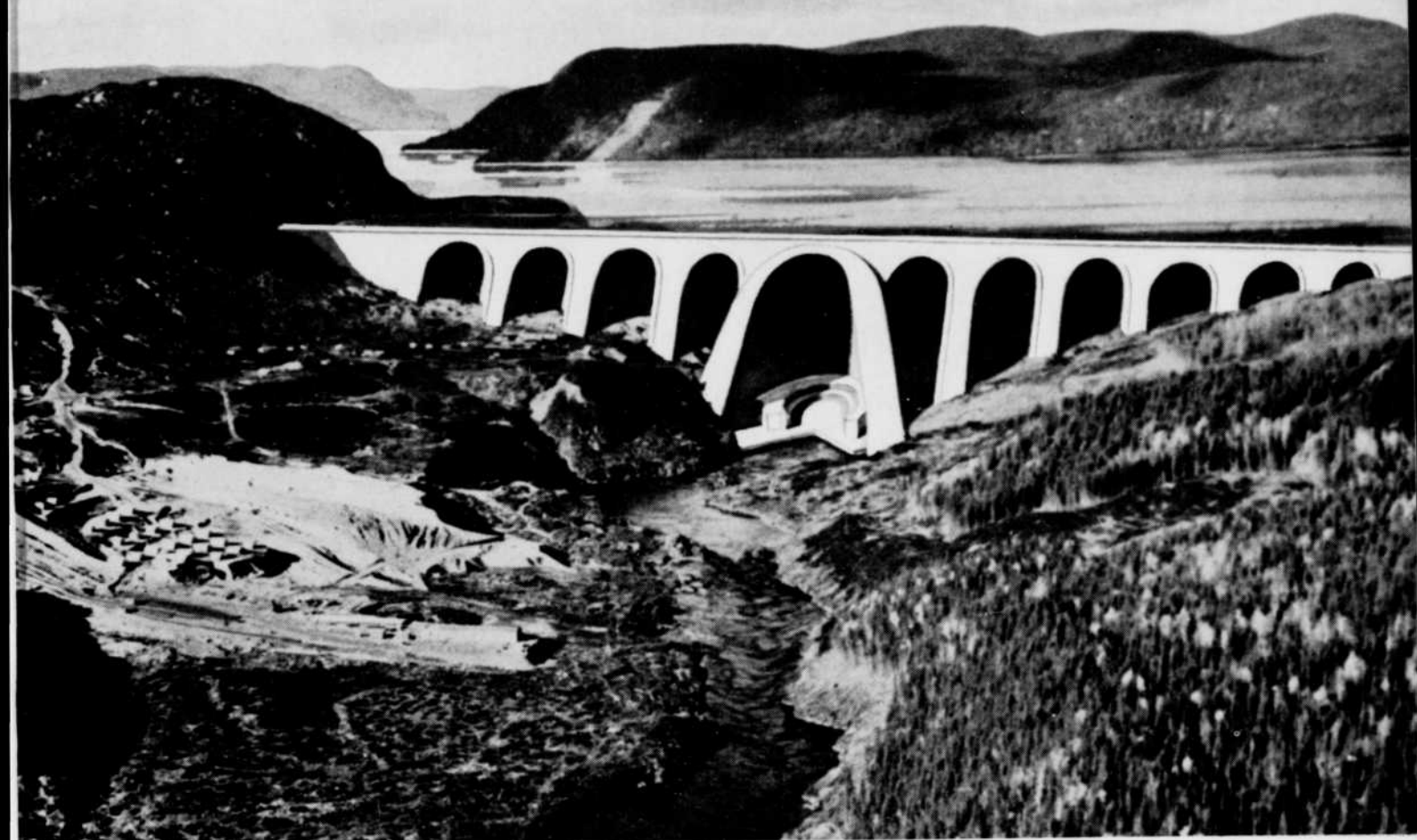
Esquisse de l'établissement No 5, une fois terminé. Ce barrage de 600 pieds d'épaisseur à la partie centrale de sa base, requerra près de 2,5 millions de verges cubes de béton et créera un réservoir de 800 milles carrés.
