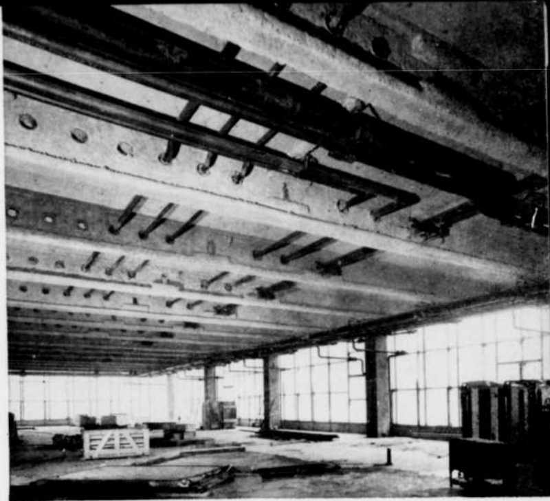
Les tuyaux d'eau et de chauffage passent à travers les poutres d'acier.
