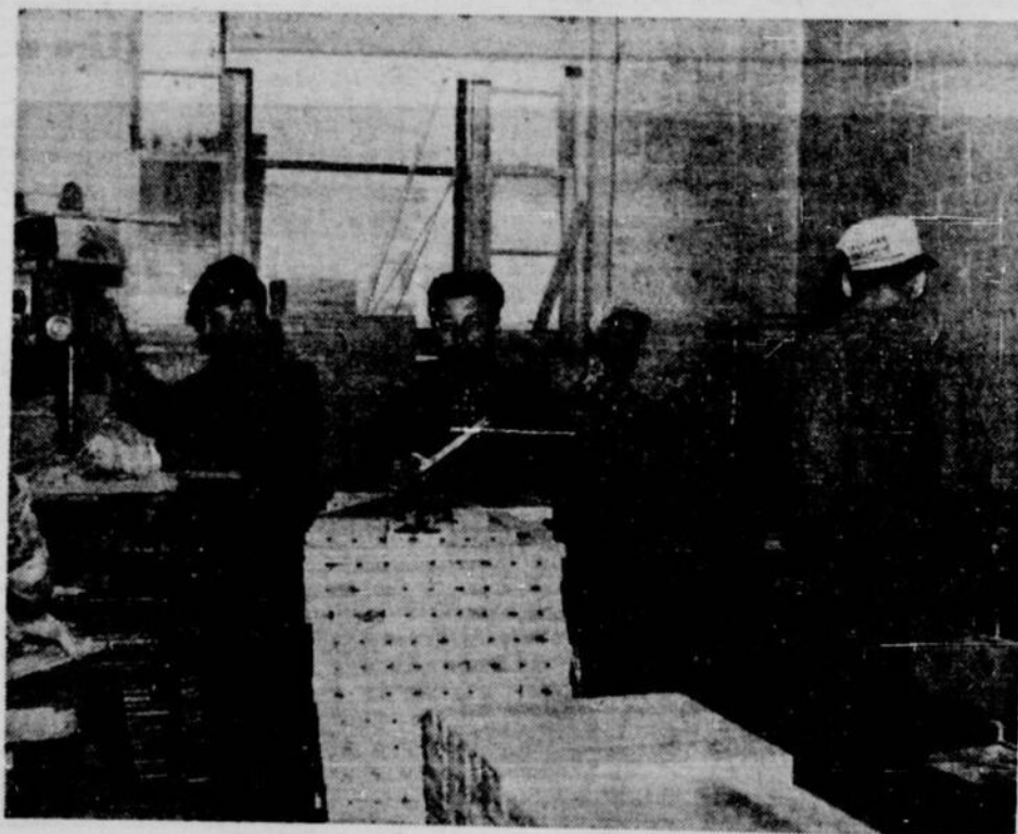
LES MOULURIERS — A la faveur d'un outillage moderne, ces ouvriers néo-canadiens exécutent de délicates moules qui entreront dans la fabrication de cabinets de télévision. Au centre, le contremaître John Markulik, ébéniste originaire de Vienne. Ses camarades de travail sont : le Belge, Henri Lerry, le Grec, Franz Kouskoussis, et le Yougoslave, Wolfgang Debler.
