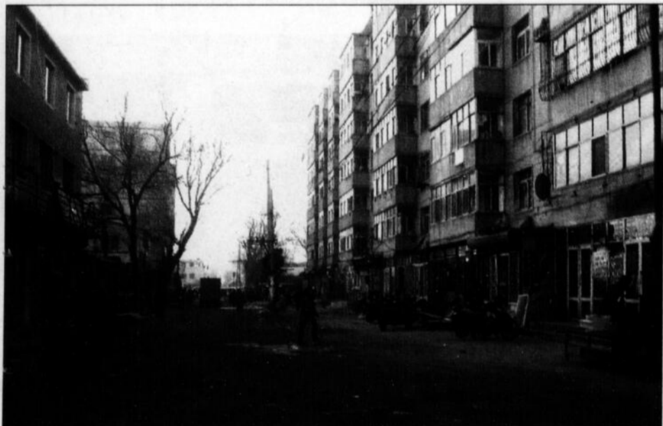
Tout ce quartier est appelé à être démoli.
