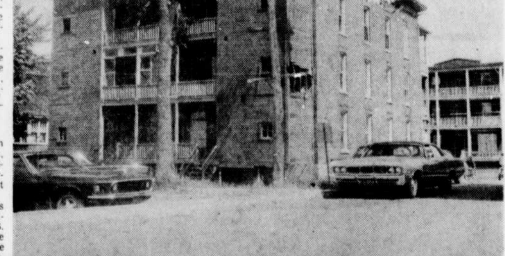
ELLE SERA DEMOLIE — Une des autres "beautés" de Drummondville est appelée à disparaître prochainement. Il s'agit de l'édifice à logements sis immédiatement à côté de l'édifice provincial, sur la rue Marchand, et qui a été considérablement endommagé par le feu l'année dernière. En vertu du règlement municipal, cette bâtisse, qui depuis l'incendie, présentait un spectacle très désagréable à la vue et un danger pour les enfants, qui pouvaient facilement s'y introduire, n'avait pas encore été réparé. Cependant, elle sera maintenant démolie puisque le gouvernement provincial viendrait de faire l'acquisition de cet édifice, appartenant à Mme Eva Papin, pour faire place à du stationnement pour l'édifice provincial et pour agrandir le stationnement qui existe actuellement. On ne sait pas encore, cependant, quand la démolition débutera. (Photo La Tribune, Drummondville)
