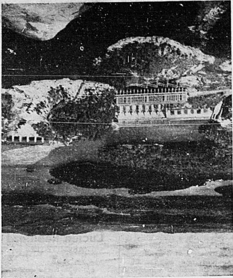
L'usine Paugan, de la Gatineau Power Company, sur la rivière Ottawa. Outre cette centrale, d'une puissance de 238,000 horse-power, la Gatineau Power en a cinq autres.
