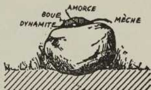
Fig. 129—Tirage en surface ( mudcapping ) bien placé; la couverture de boue doit avoir plusieurs pouces d'épaisseur.
