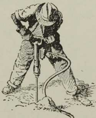
Fig. 77—Marteau perforateur en usage dans les travaux de construction de route.
