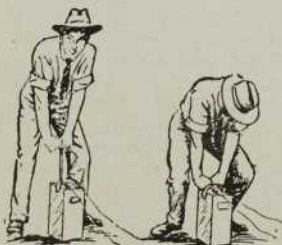
Fig. 65—Mode d'emploi d'un exploseur à poignée.
