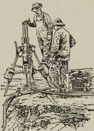
Fig. 78—Perforatrice sur affût-trépiéd en état de fonctionnement.
