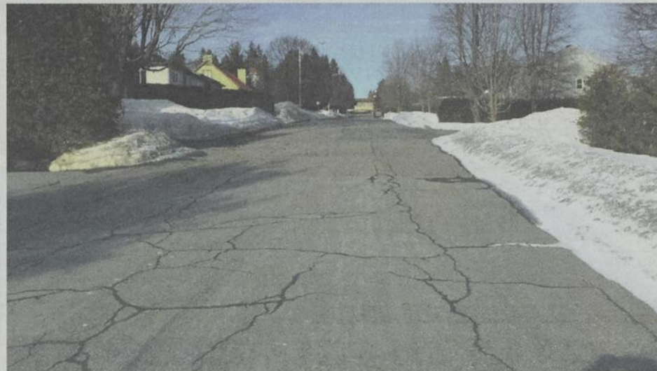
La Ville de Saint-Georges réalisera des travaux majeurs dans la 125 e Rue.
