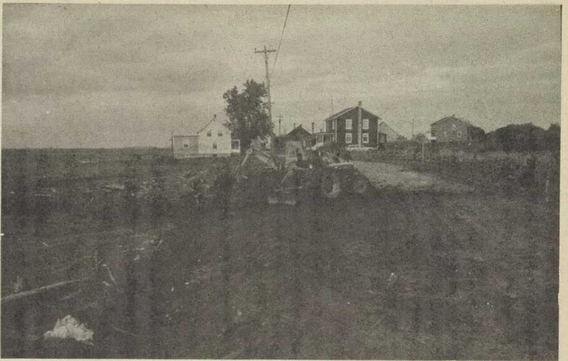
D'importants travaux de voirie se font actuellement à l'Île-aux-Grues. Il s'agit des travaux exécutés dans cette section du comté depuis 1960.
