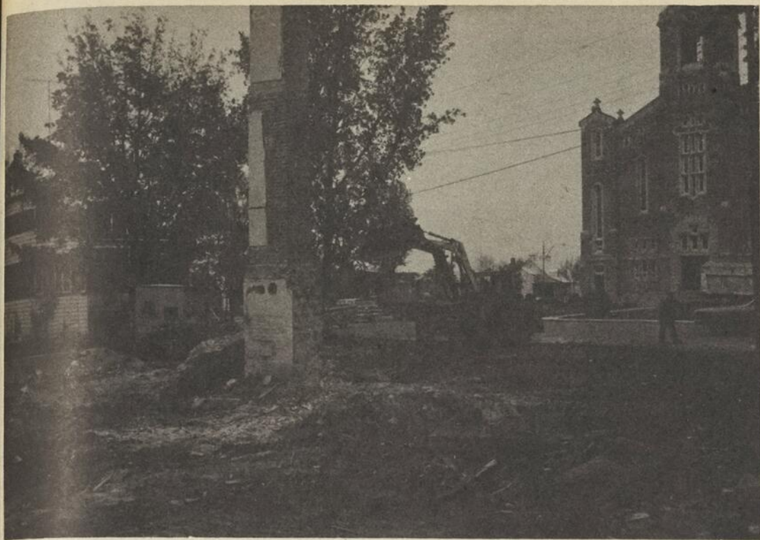
DERNIER VESTIGE - Cette cheminée constitue le dernier vestige de la maison qui abritait les bureaux de la commission scolaire régional P.-Taché jusqu'au début du mois d'octobre. C'est sur ce site que s'élèvera bientôt le magnifique édifice de la Caisse Populaire St-Thomas.
