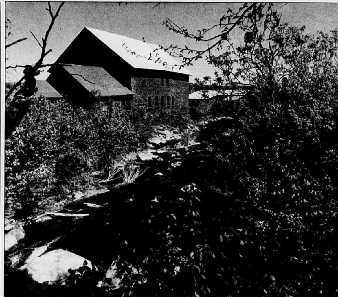
Un vieux moulin dans les Cantons de l'Est.
