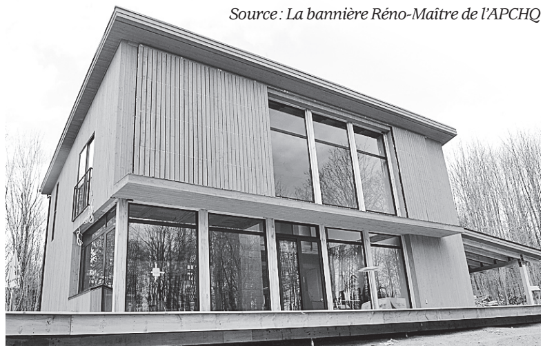
PHOTO DANIELLE FRANCIS, ARCHIVES LA VOIX DE L'EST Exemple d'une maison entièrement écologique à Lac-Brome.
