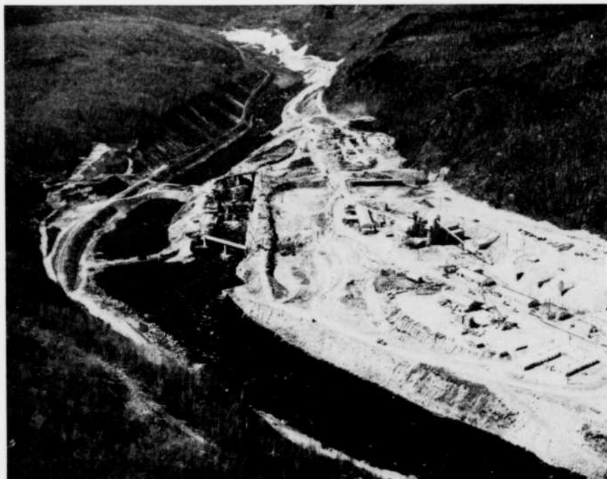
Fig. 2 — Vue aérienne du chantier de Beaumont, peu de temps après l'ouverture du canal de dérivation où passent les eaux du St-Maurice. Le lit de la rivière a ensuite été asséché pour permettre la construction du barrage principal et de la centrale.
