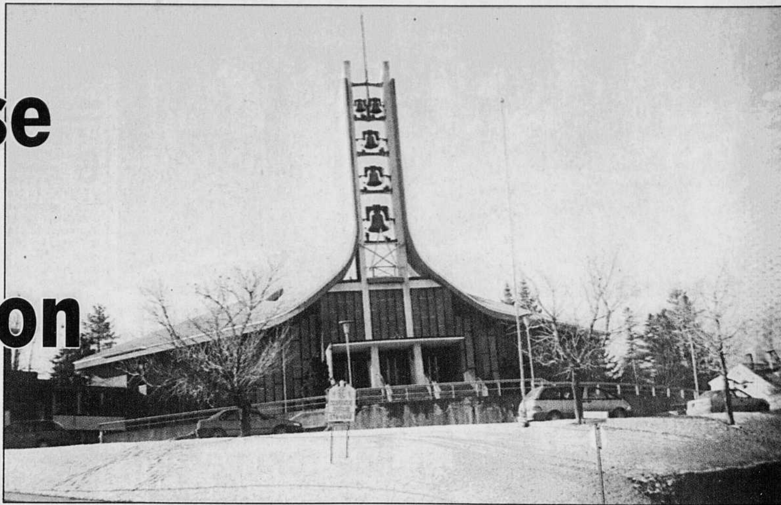
Photo La Tribune, par Sylvie Pion L'église Saint-Aimé possède une architecture spéciale, créée par un architecte montréalais. Elle représente deux mains unies vers le ciel. Après s'être impliquée 26 ans à l'église Saint-Aimé lors des célébrations dominicales, la mairesse Louise Moisan-Coulombe annonce que la Ville lui donnera une nouvelle vocation.
