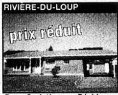
RIVIERE-DU-LOUP Rue Coristine : Résidence 4 chambres à coucher avec abri d'auto et garage. (1956)
