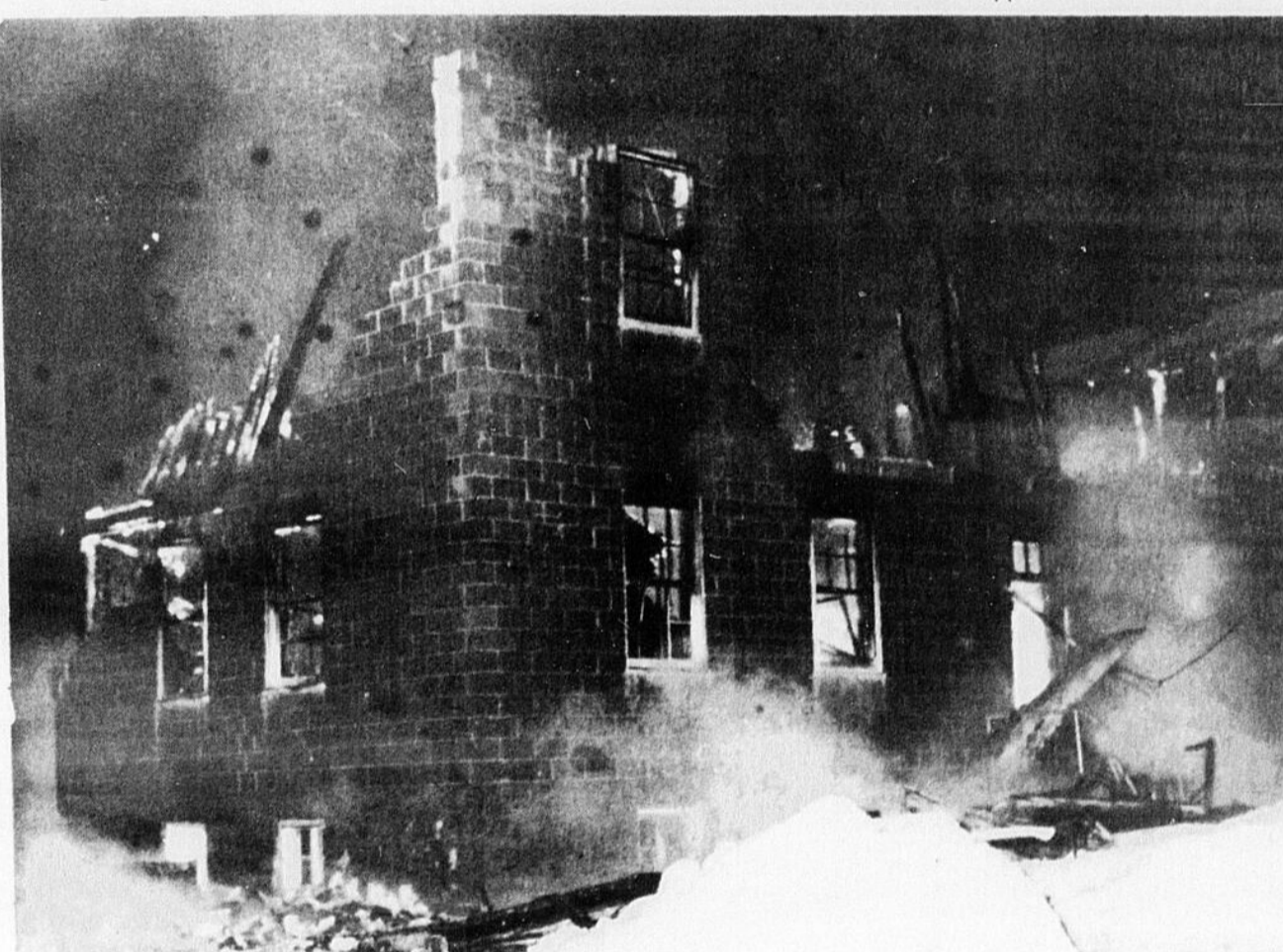
Les flammes ont détruit une maison de deux étages mercredi soir dernier, à Herdman. 18 personnes furent chassées de leur domicile. Cette maison était une ancienne école. Elle abritait maintenant quelques familles et appartenait à M. Allan Davignon. Ce fut une perte totale, et les gens perdirent la majorité de leurs biens matériels.
