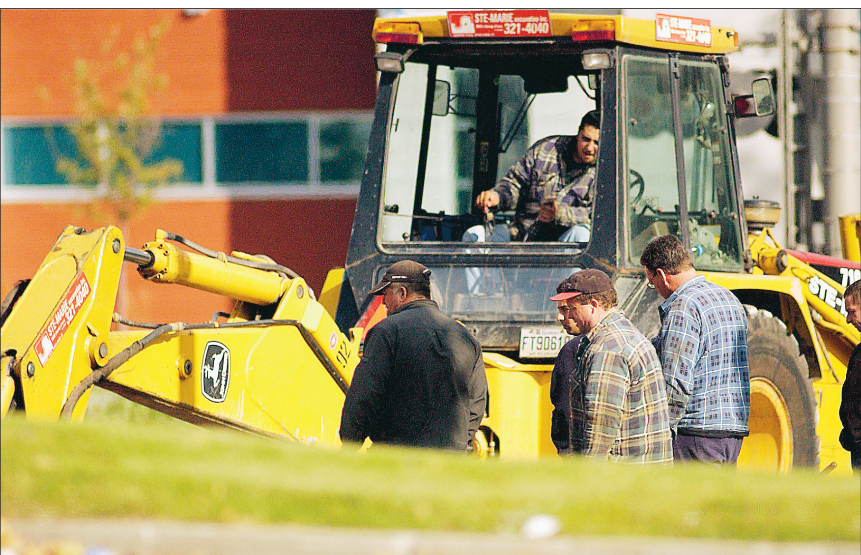
Ces cols bleus travaillaient hier sur un chantier, rue Bridge, près du pont Victoria.
