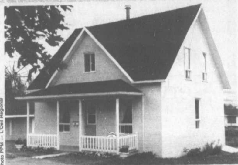
Le propriétaire qui habite cette maison a bénéficié d'une subvention de 5 000 $ dans le cadre du programme PARCQ. Des travaux majeurs de rénovation y ont été effectués rendant ainsi ce bâtiment conforme aux normes de sécurité et de salubrité.
