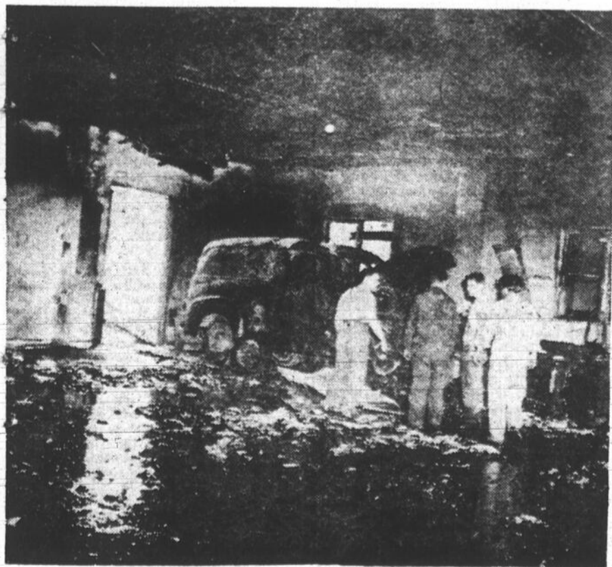
L'intérieur du garage détruit par le feu à Laprairie (Photo "Montréal-Matin")
